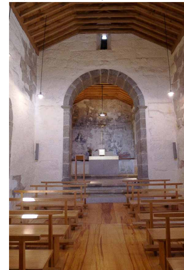
Interior da Igreja Românica S. Mamede Vila Verde, Felgueiras depois da intervenção. Foto: Acervo da autora.
