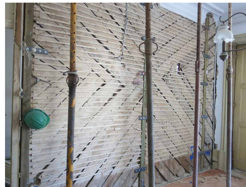
Casa Belos Ares, reforço da parede de tabique. Foto: Acervo dos autores.
