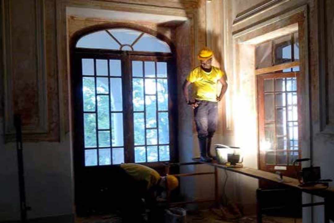
Execução de molduras em gesso. Acervo do autor.
