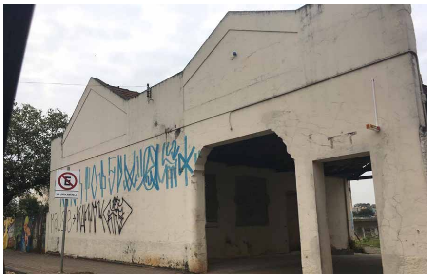
Barracão de uma antiga fábrica, com fachada que era voltada para a Avenida Campinas e área de carga e descarga voltada para a linha férrea. Também é utilizada como estacionamento. Foto: Acervo dos autores, 2017.
