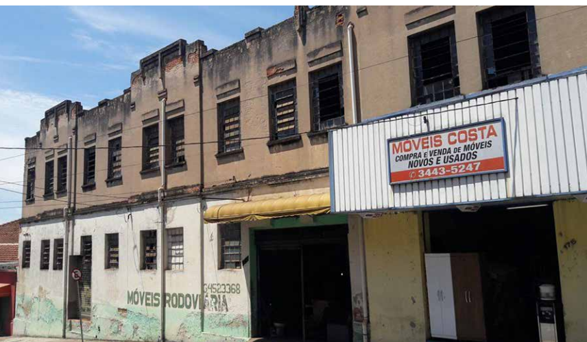
Barracão próximo à ferrovia. Imóvel, de inspiração art déco , provavelmente construído na década de 1940 e seu uso como depósito é posterior. Muitos dos imóveis desta área foram transformados internamente, sem nenhuma diretriz de preservação. Foto: Acervo dos autores, 2017.
