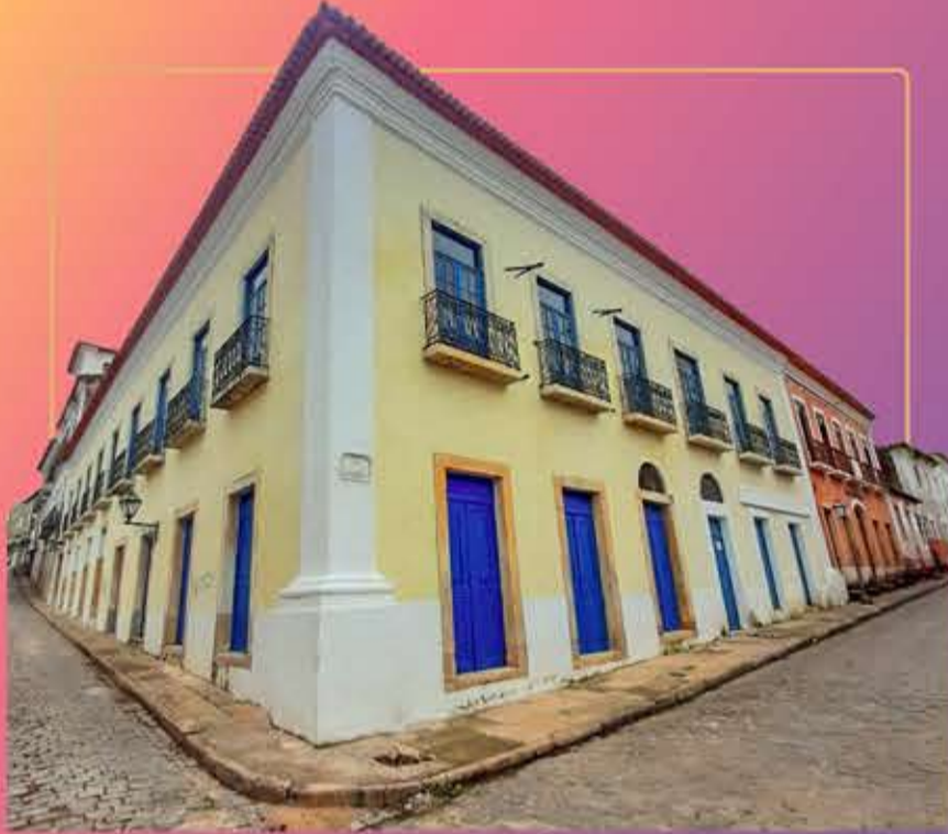
Casarão Rua da Palma 195 e 205 após a intervenção
