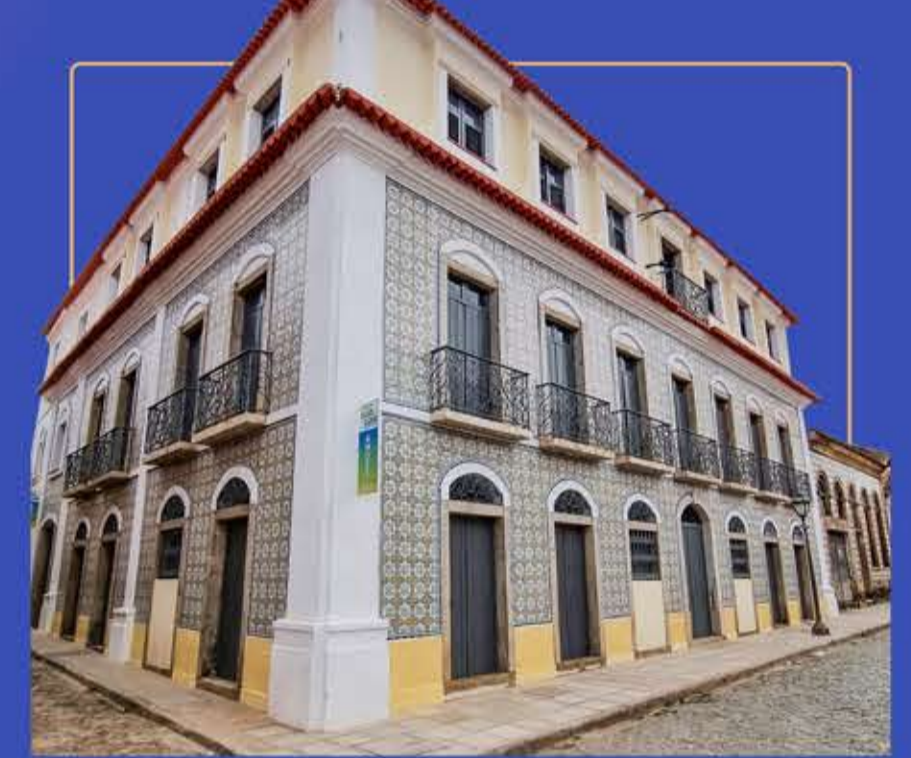
Casarão Rua do Giz 445 após a intervenção
