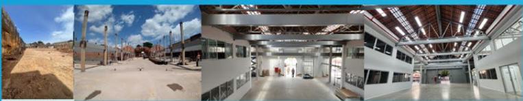
Figura 5-Da esquerda para direita, sequência do andamento de obra no primeiro galpão, vista do acesso principal. Fonte: Fumph 2023/2025.
