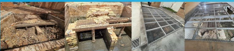
Figura 7- Processo de intervenções nos tanques de arrefecimento, é possível observar uma estrutura em tijolos maciços e pilares de ferro fundido, estruturas industriais associadas a Usina da Ulen & Company. Fonte: FUMPH (2023/2025).
