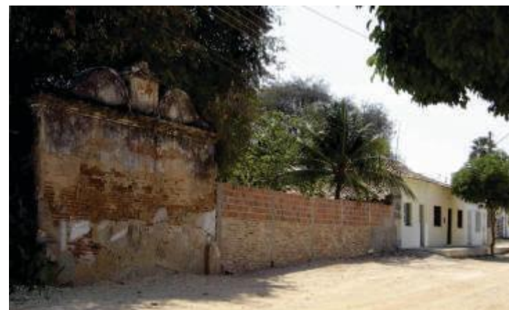
Figura – Aspecto da Cacimba do Povo no ano de 2005 (edifício a esquerda da foto). Fonte: Fotografia do autor (2005).
