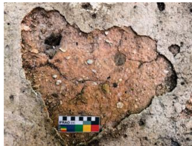
Figura 2 – Argamassa histórica contendo fragmentos conchíferos compatíveis com materiais associados a depósitos sambaquieiros utilizados como matéria-prima construtiva na Fortaleza de Santa Cruz de Anhatomirim. Fonte: Acervo do autor (2026).
