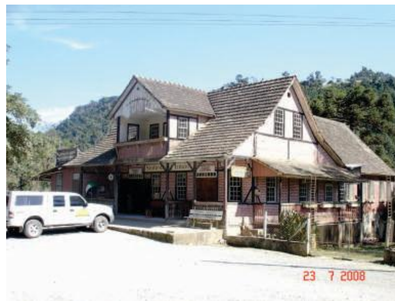
Figura 1: Casarão Stoltenberg, vista da estrada. Fonte: IPHAN (2008).
