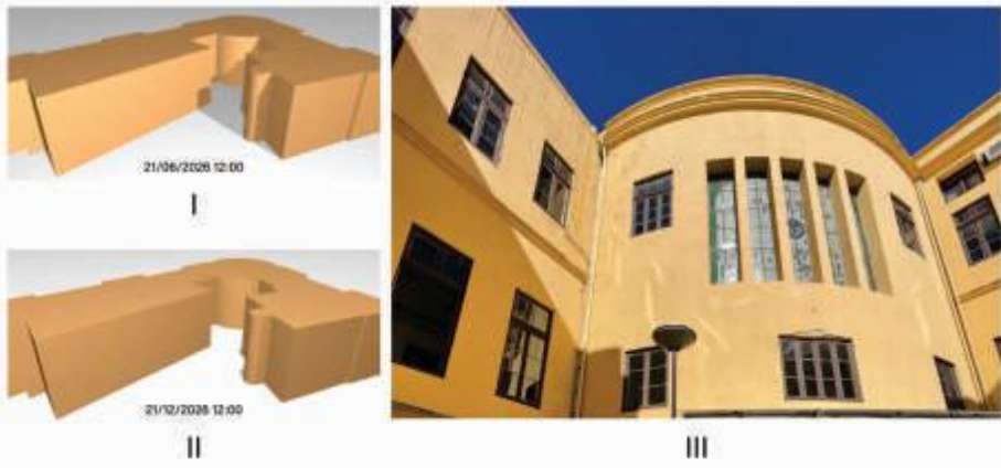
Figura 7: Projeção da sombra ao meio dia nos solstícios de inverno (I) e verão (II); vista externa da parede afetada (III). Fonte: os autores.
