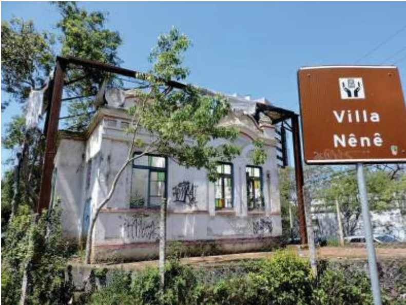
IMAGEM: ESTADO ATUAL DA FACHADA - Foto: Alisson Moura - PMC
