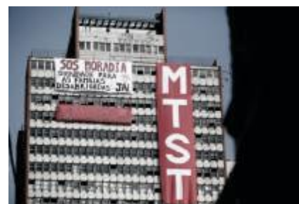
Figura 1 - Fachada do edifício do INSS após a ocupação. Nota: foto de Jonathan Heckler for Agência RBS, 2024
