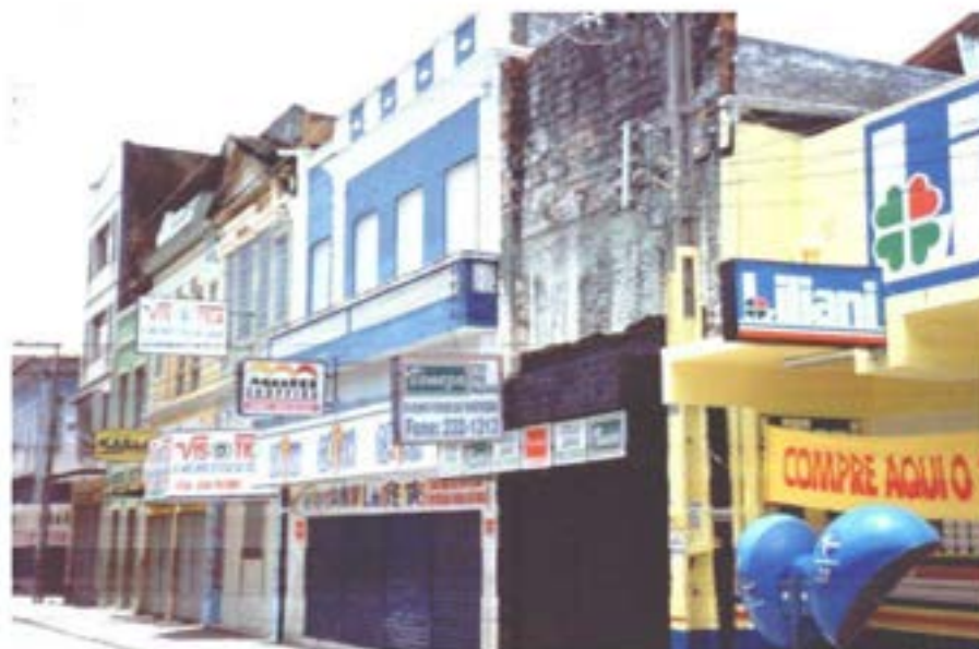
Figura 04 - Descaracterizações ocorridas na Rua Grande (2000)
