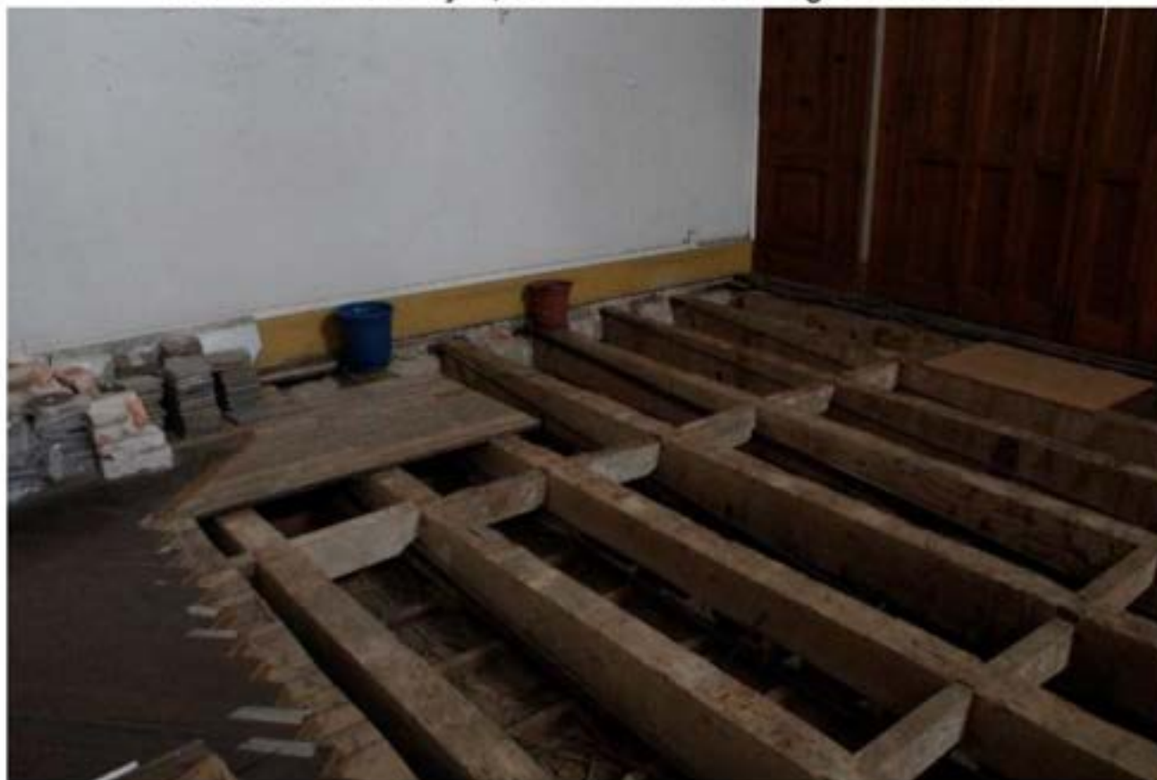
Fig. 6: – Sala do primeiro andar, sobre a biblioteca, notando-se a estrutura de madeira, com vigas contínuas numa direção, com travamento de vigas denteadas.
