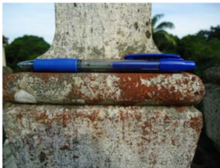
Figura 2: Balaústre com colonização biológica.
