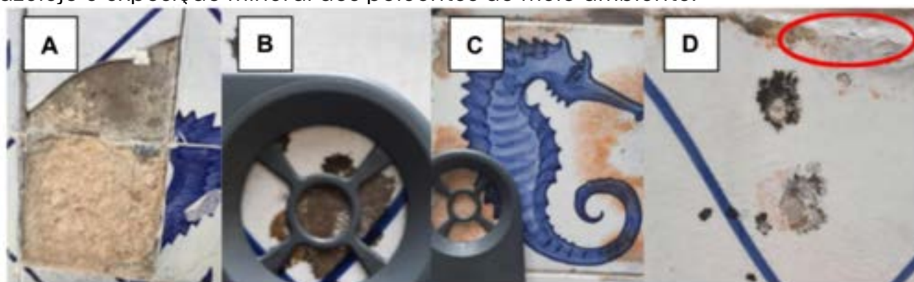
Figura 3: (A) Perda de massa; (B) Propagação negra; (C) Propagação rosa; (D) Perda de massa.
