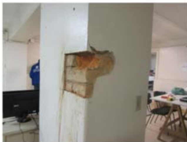
Investigação para verificação em elementos estruturais.
