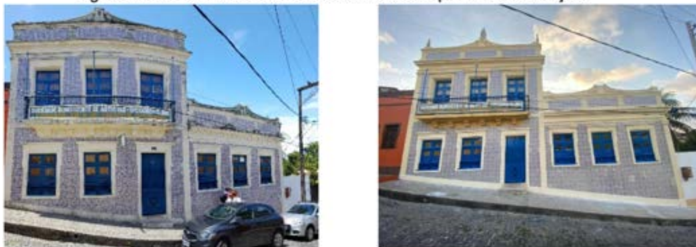
Figura 1 e 2 – O Sobrado da SBAOO antes e depois da intervenção.
