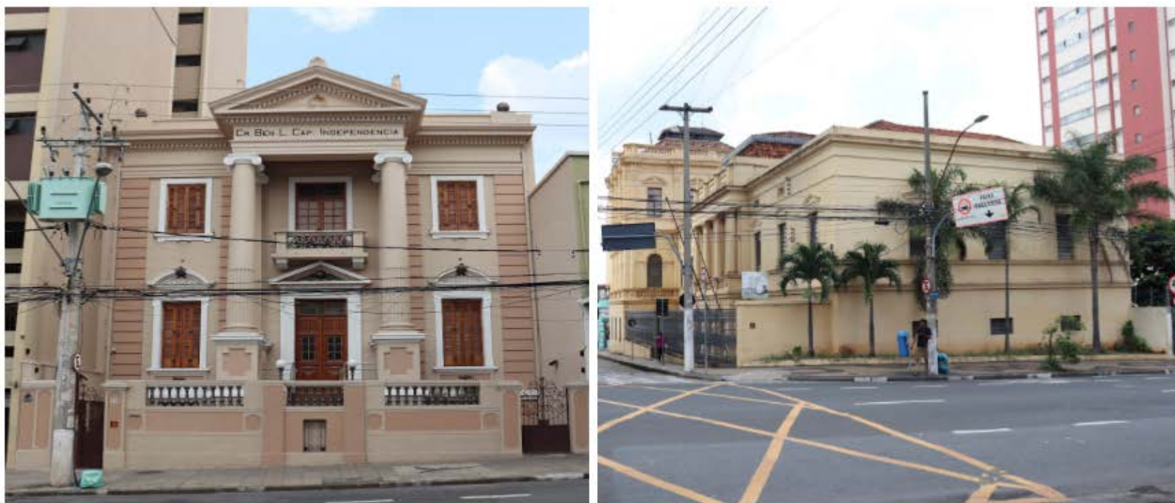
Fig. 02. Avenida Campos Sales. Imóveis patrimoniais.
