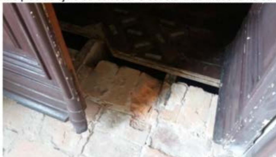
Fig. 7: Transição entre piso de tijolo do corredor e estrutura de madeira na sala, no primeiro andar.
