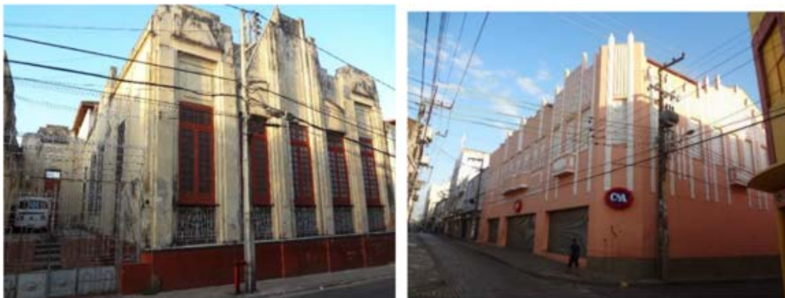
Figura 5 - Residência da família Cavalcanti, Rua do sol 467, São Luís. Fonte : Pflueger , 2015 Figura 6- Loja da C&A, Rua Grande, São Luís. Fonte: acervo pesquisa UEMA /FAPEMA – Pflueger, 2011
