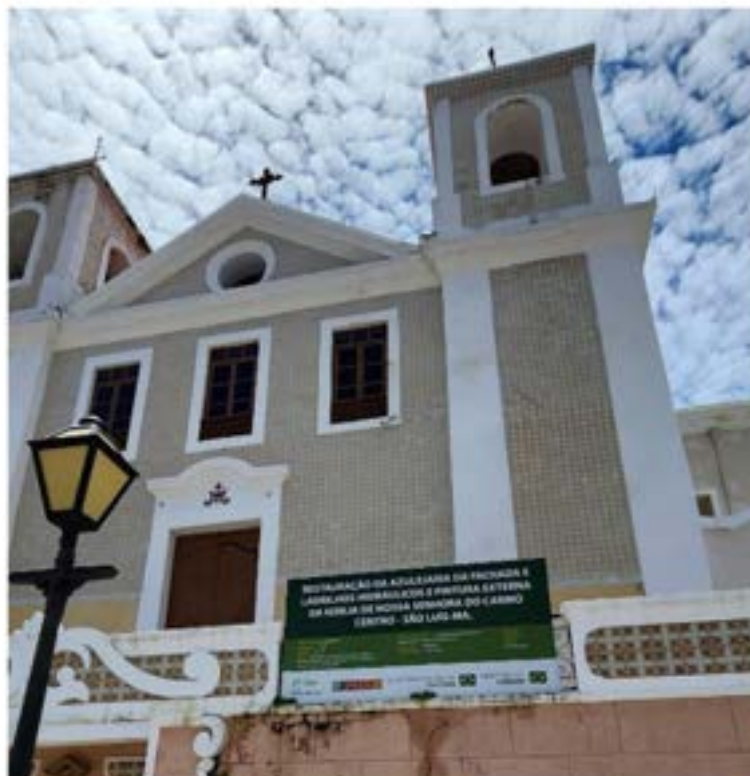
Figura 4: Restauração da azulejaria da fachada da Igreja de Nossa Senhora do Carmo. Foto: Margareth Figueiredo 2023
