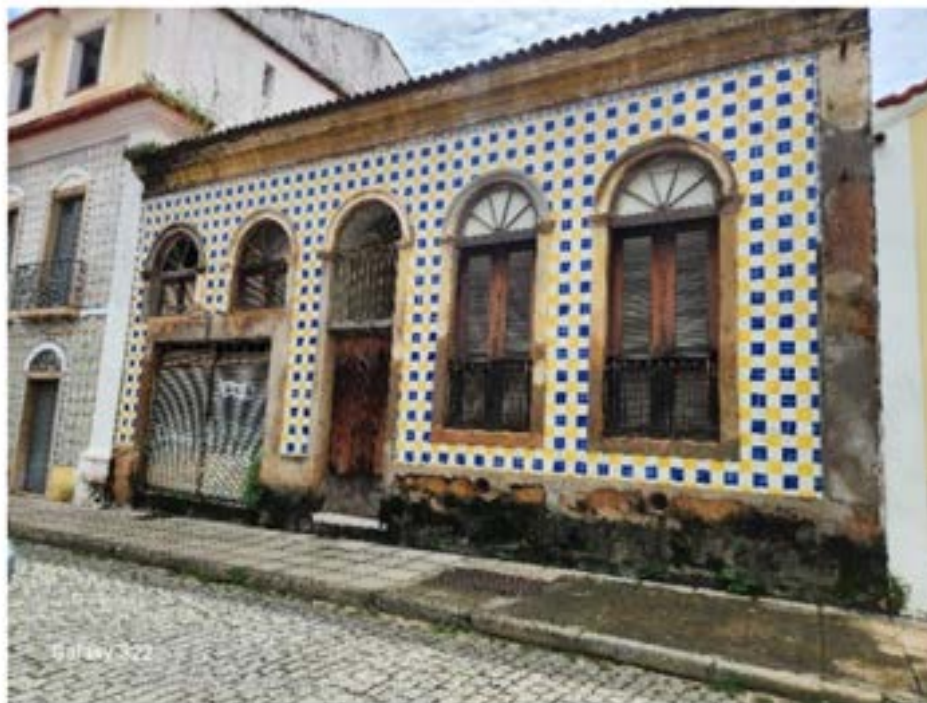
Figura 3: Rua do Giz, 461, imóvel que teve os azulejos antigos retirados e substituídos por azulejo industrial com o mesmo padrão do original. Foto: Margareth Figueiredo – 2023
