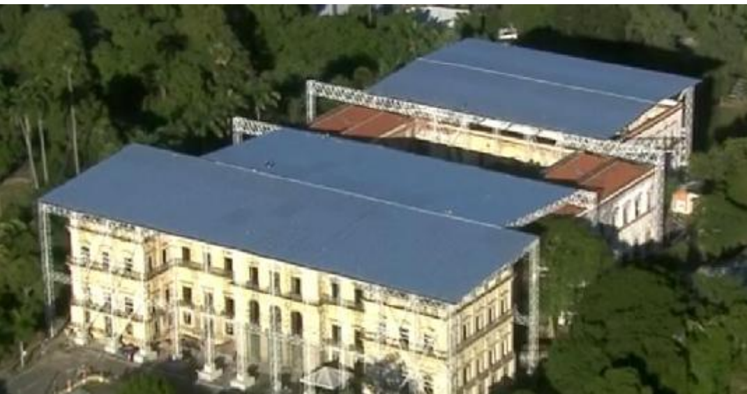
Figura 5 – O Museu Nacional recebe cobertura provisória em material metálico. Disponível em: < https://oglobo.globo.com/rio/museu-nacional-tem-instalacao-de-telhado-provisorio-concluida-23731917 >. Acesso em 09/03/2020.
