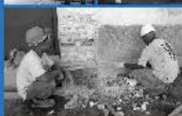
RESTAURAÇÃO DE ELEMENTOS ORIGINAIS ORIGINAL ELEMENTS RESTORATION
