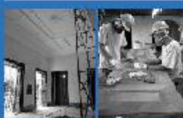
RESTAURAÇÃO DE ELEMENTOS ORIGINAIS ORIGINAL ELEMENTS RESTORATION
