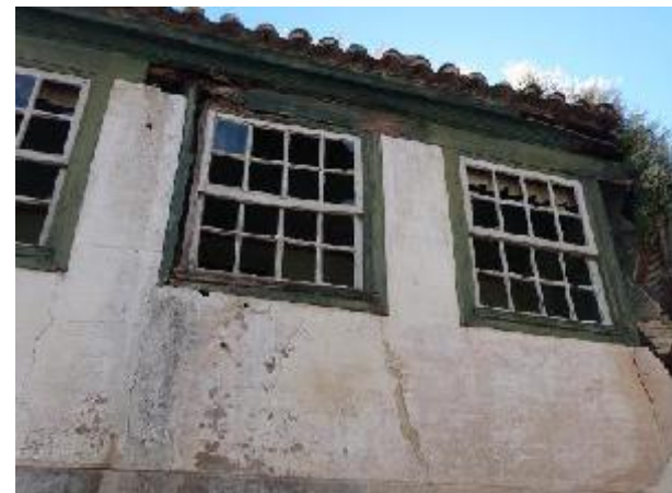
Figura 5 - Estrutura de gaioleiro sobre estrutura de pedra, Castelo Mendo. Fonte: Foto de Alice Tavares.
