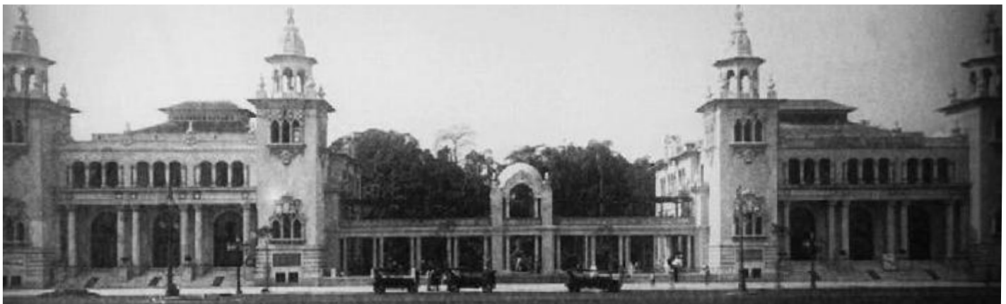
Figura 5 — Os Pavilhões do Passeio Público: Teatro Casino (à esquerda) e Casino Beira-Mar (à direita), já em funcionamento. Fonte: SANTUCCI, 2005, p. 35.
