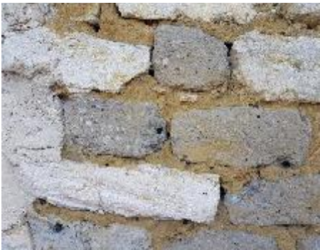
Figura 8 – Paredes com adobe de cal e adobe de terra, Aveiro. Fonte: Foto de Alice Tavares.
