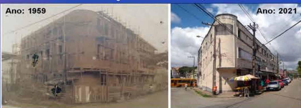
Edifício Saluá – Av. Magalhães de Almeida, nº não identificado.
