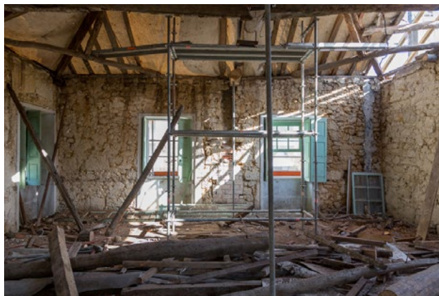
Fig. 3 – Casa Salabert – vista geral das paredes de alvenaria
