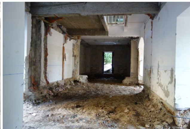
Fig. 4 – Casa Salabert – fundações das paredes de alvenaria
