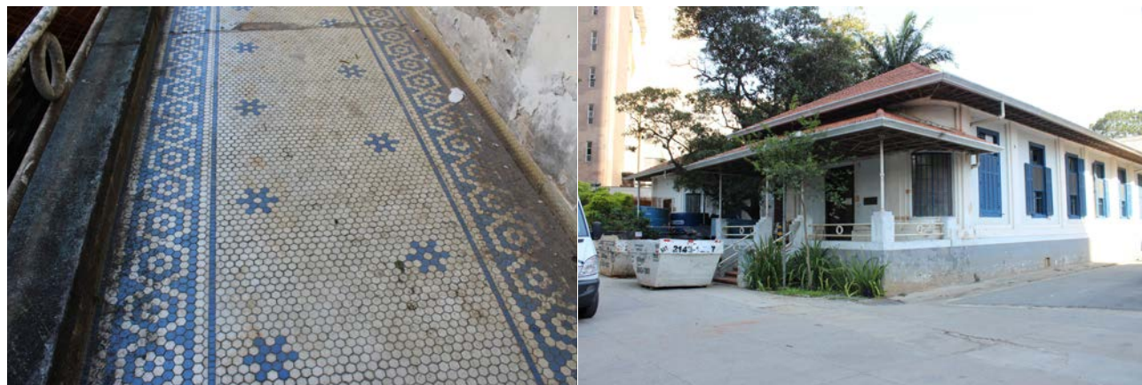
Figura 9: Piso hidráulico utilizado na varanda do Pavilhão 2. Fonte: Paulo Fraga Slveira, 2002.
