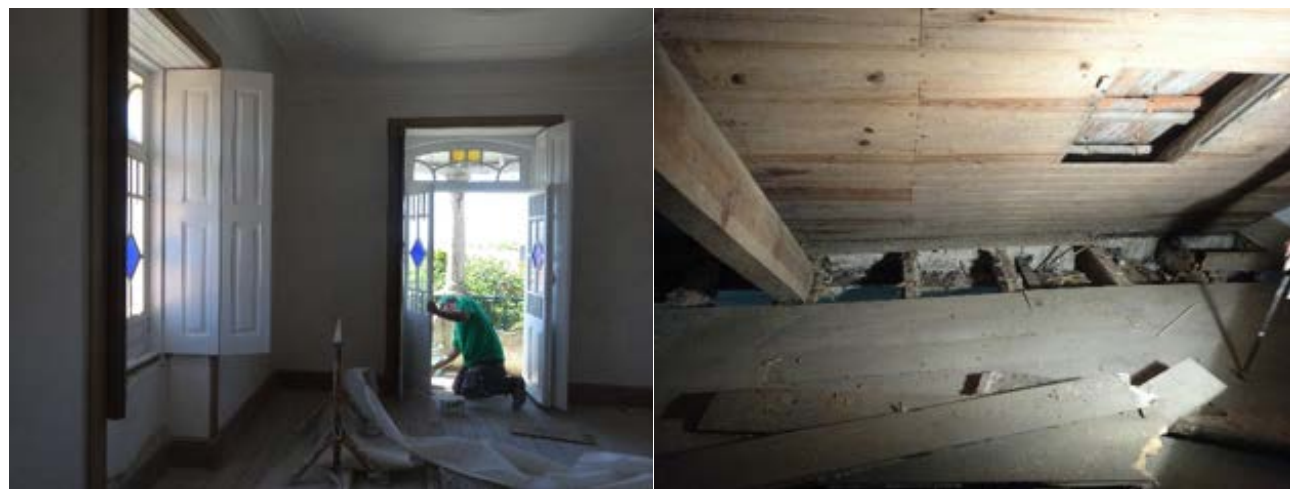
Figura 28 – Intervenção na caixilharia, reabilitando a existente
