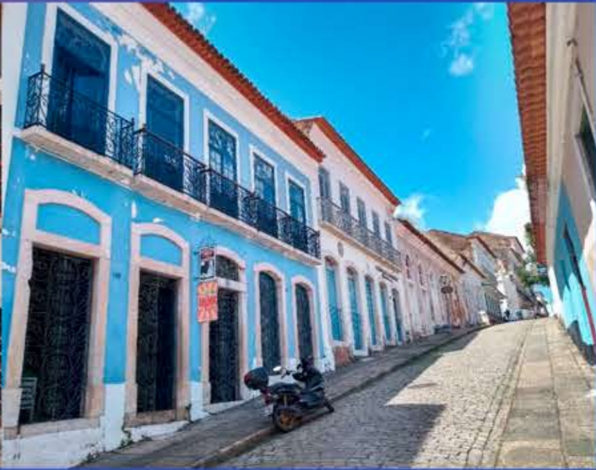
Sobrados da Rua do Giz. Fonte: GALDINO, 2021
