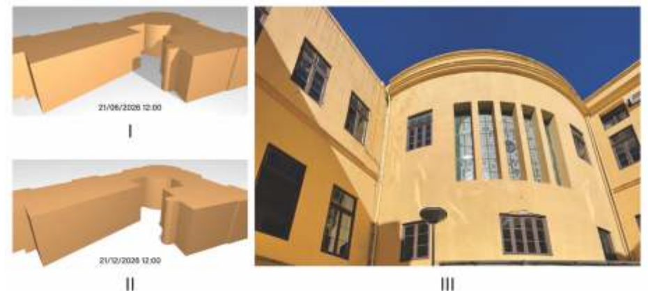
Figura 7: Projeção da sombra ao meio dia nos solstícios de inverno (I) e verão (II); vista externa da parede afetada (III). Fonte: os autores.
