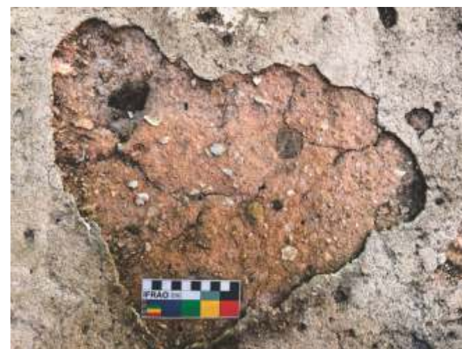
Figura 2 – Argamassa histórica contendo fragmentos conchíferos compatíveis com materiais associados a depósitos sambaquieiros utilizados como matéria-prima construtiva na Fortaleza de Santa Cruz de Anhatomirim. Fonte: Acervo do autor (2026).
