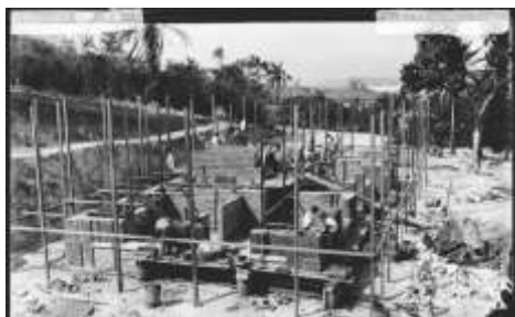
Imagem 5 - Construção Pavilhão do Relógio Foto: Casa de Oswaldo Cruz, 1904.
