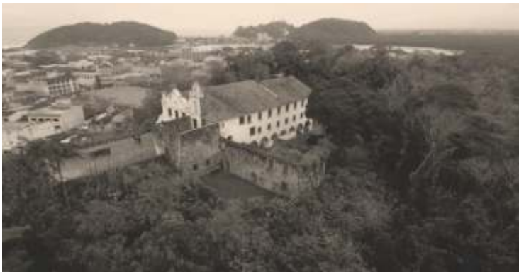
Figura 1: Vista do Convento Conceição de Itanhaém, foto 2025, feita com drone por Carlos Eduardo da Silva, 2025, para o levantamento topográfico atualizado do morro Itaguassú.
