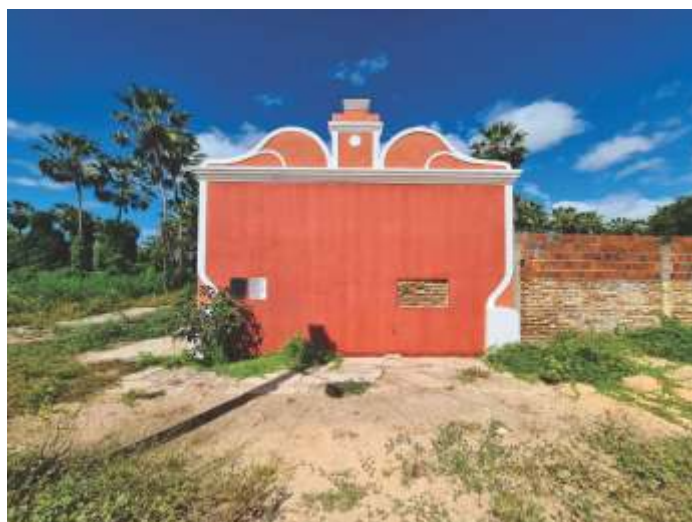
Figura - Cacimba do Povo após obras de restauro. Fonte: Fotografia do autor (2023).
