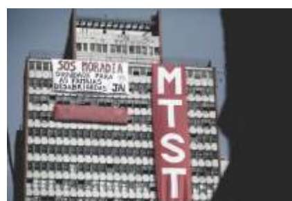
Figura 1 - Fachada do edifício do INSS após a ocupação. Nota: foto de Jonathan Heckler for Agência RBS, 2024
