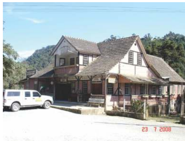
Figura 1: Casarão Stoltenberg, vista da estrada. Fonte: IPHAN (2008).
