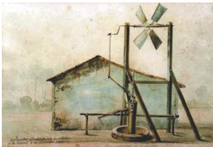
Figura - Moinho de vento nos arrebalde do Aracati. Todo fabricado de carnaúba (1959). Fonte: CARVALHO (1859)
