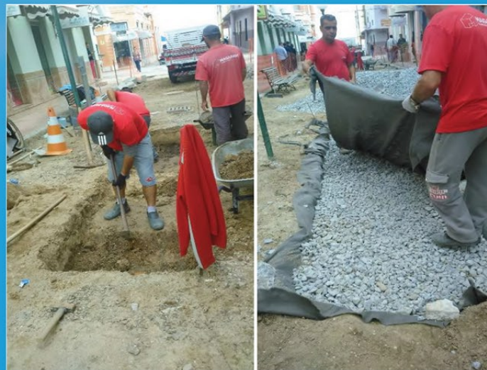
Figuras 2 e 3 – Locação, escavação e execução do canteiro pluvial no Calçadão da Rua XV de Novembro, 2016.
