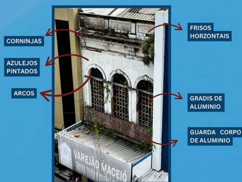
Figura 02 - Análise tipológica da fachada: elementos remanescentes identificados in loco.
